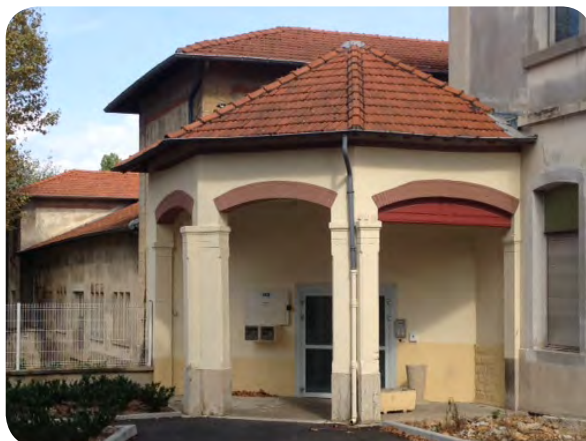
Entrée de l'UHCD - Bâtiment 409
